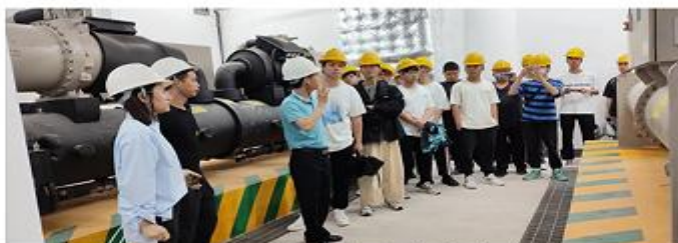
大型中央空调机房现场教学
