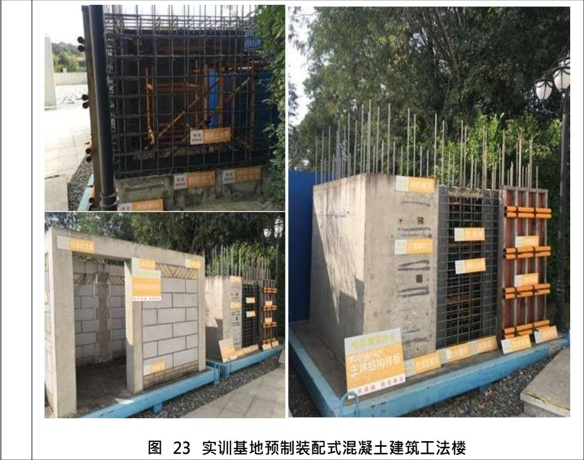
图 23 实训基地预制装配式混凝土建筑工法楼
