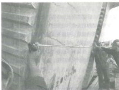
图1 桥梁裂缝测量
