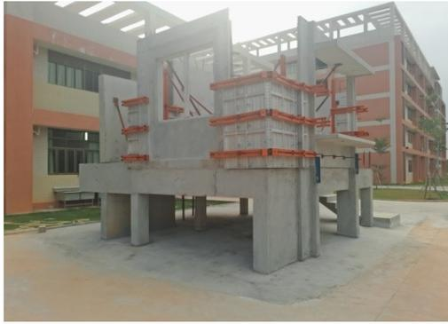
图 2.10 捐建的装配式建筑工法楼
