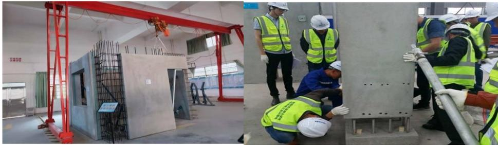
图 2.2 装配式构件安装施工实训室
