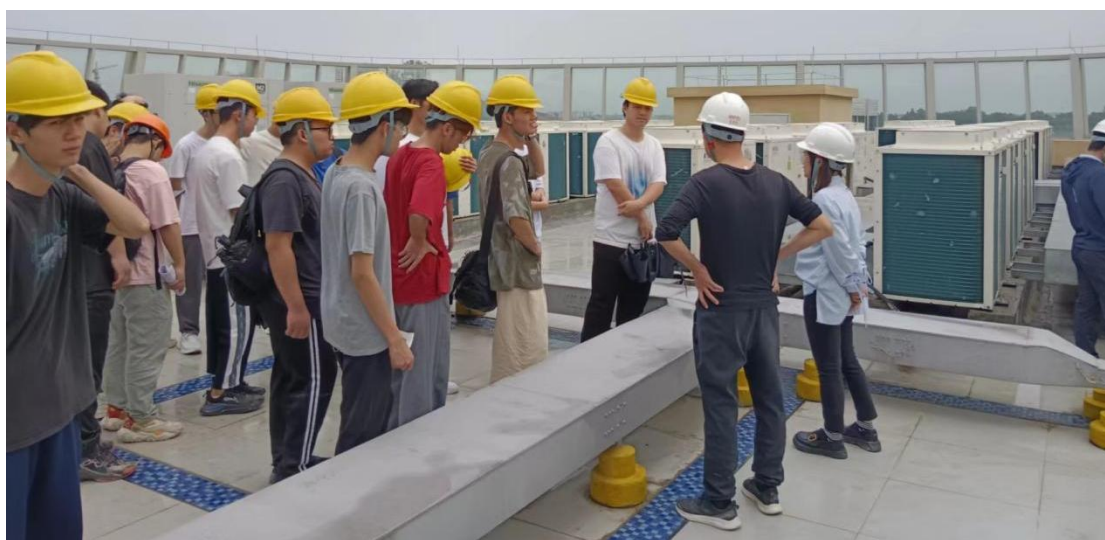
家用中央空调系统室外机、恒温恒湿系统外机布置现场教学
