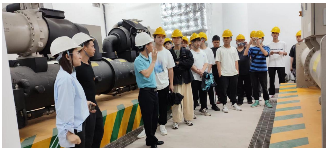
大型中央空调机房现场教学
