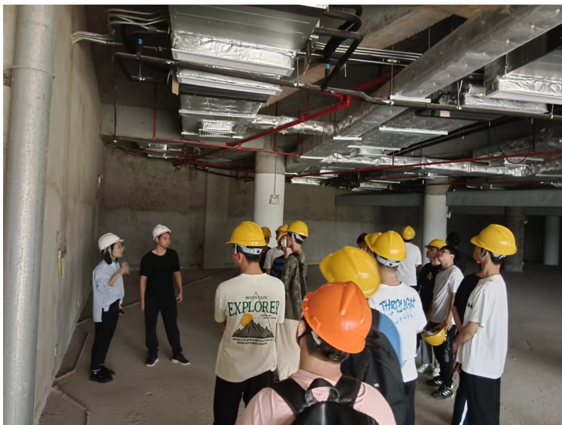
家用中央空调系统室内机布置现场教学
