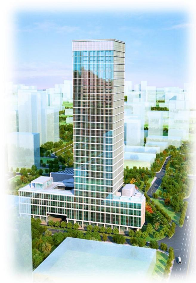
深圳广电金融中心位处深圳市福田区福中三路与新洲路交汇处，总建筑面积约**23**万平方米，建筑高度**231.7**米标准层层高**4.3**米，主楼结构形式为钢管混凝土-钢筋混凝土核心筒结构，裙房为框架结构、地下室为无梁楼盖结构。
